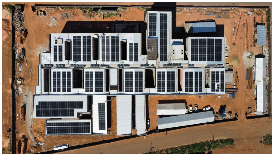
Foto da execução do sistema – Fórum de Gurupi
